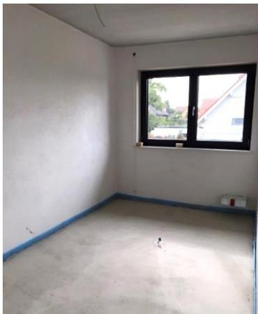
Geschosse über EG: In den Obergeschossen werden zwei Dämmschichten eingebaut, eine wird als Dämmung und eine als Trittschalldämmung ausgeführt.
